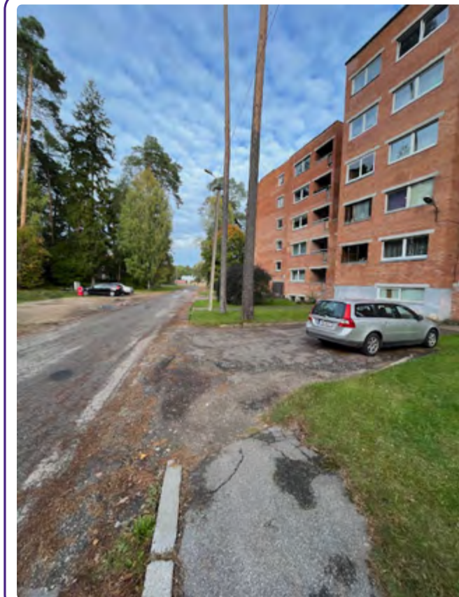
Pilt 1. Renoveerimata korterelamu ja kehvast seisust taristu Elva Nooruse piirkonnas
